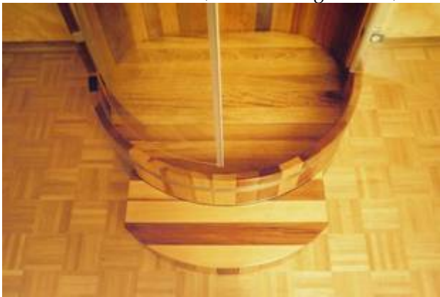
Les portes vitrées restent à l'intérieur de la cabine, ainsi l'eau s'écoule à l'intérieur sans besoin de joint
