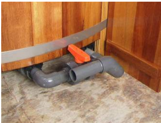
Ecoulement du trop plein et vanne de vidange du bac
