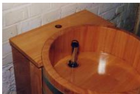
L'écoulement est raccordé par raccord 1 ¼ "
