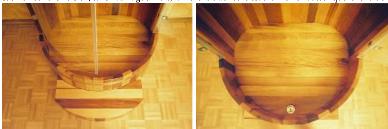
Les portes vitrées restent à l'intérieur de la cabine, ainsi l'eau s'écoule à l'intérieur sans besoin de joint
