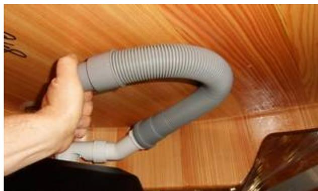
Ce tuyau PVC flexible permet de mettre la baignoire sur cales, d'effectuer le raccordement de l'évacuation, puis de redescendre la baignoire, **PLUS DE SOUCIS DE TUYAUX RIGIDES!**
